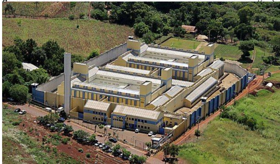
Figura 4 – Foto da estrutura física da Penitenciária Estadual de Foz do Iguaçu II.
