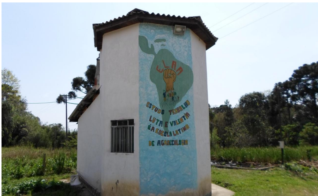
Fotografia 04: Reservatório de água 13 .
