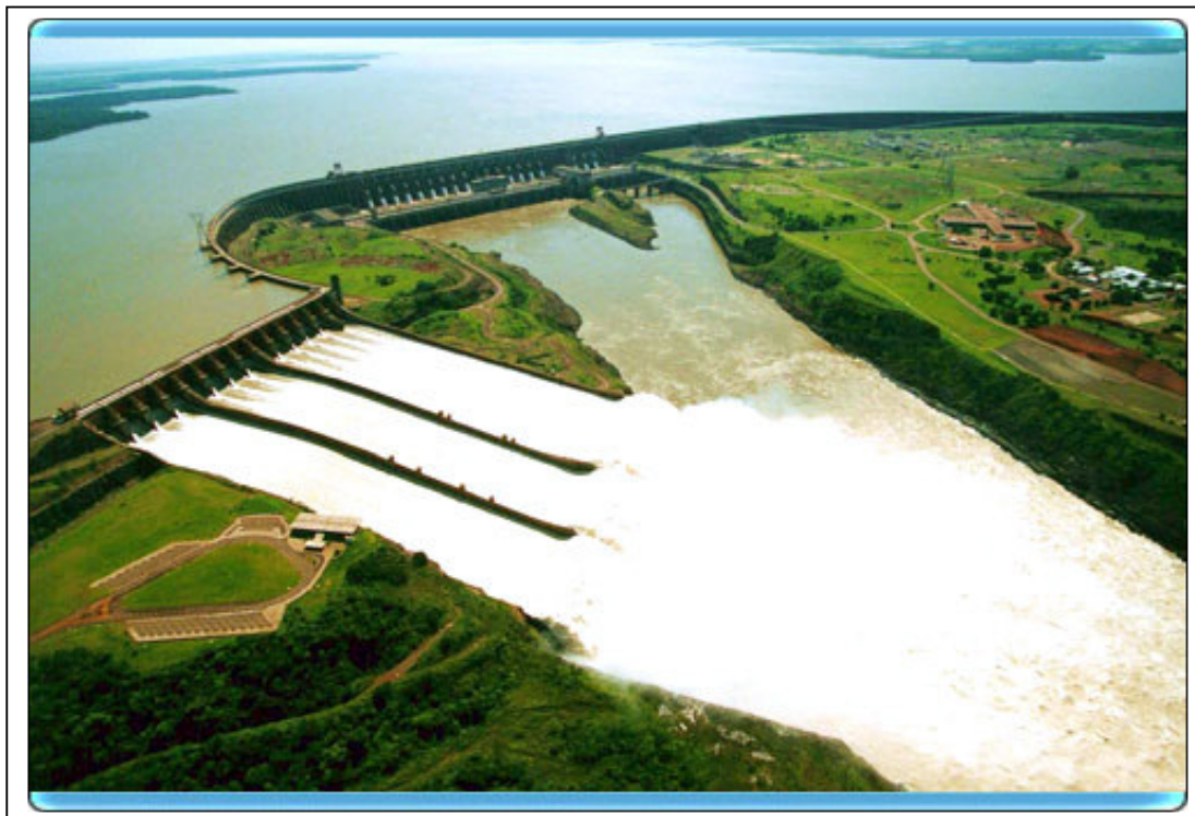
FIGURA 5 - FOTO DA REPRESA DE ITAIPU
