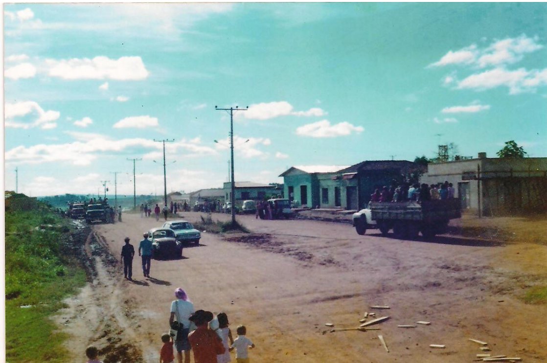
Figura 04 - Avenida principal do distrito de Itacorá por onde passava o estradaõ
