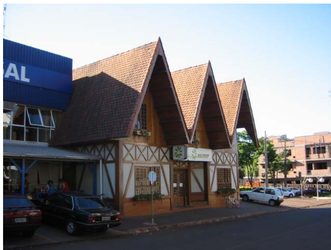
Figura 12 – Construção em enxaimel
