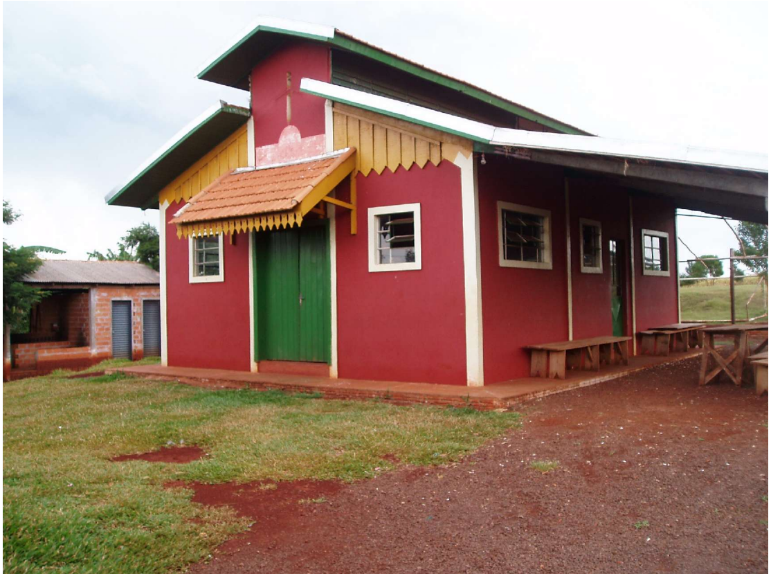
FIGURA 9 – Vista frontal do salão comunitário da Vila Rural Salto São Francisco. Aqui estão instalados os equipamentos da cozinha industrial, nos fundos fica o campo de futebol. Importante observar que o estilo arquitetônico e as cores da pintura eram definidos através de projetos elaborados por técnicos do governo do Estado do Paraná
