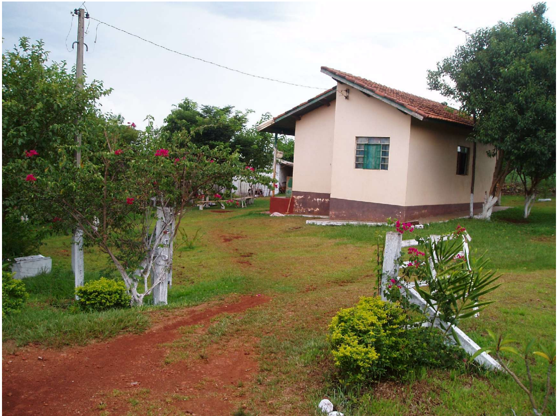
FIGURA 14 – Casa com a arquitetura original ainda mantida
