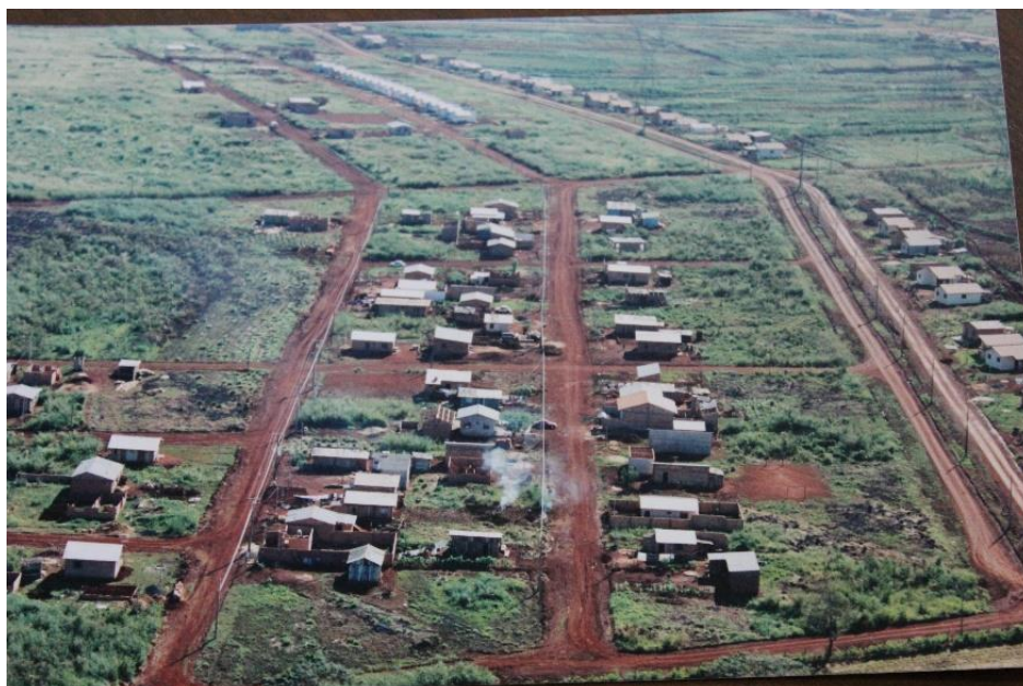
Foto: vista área das primeiras casas do Cidade Nova I
