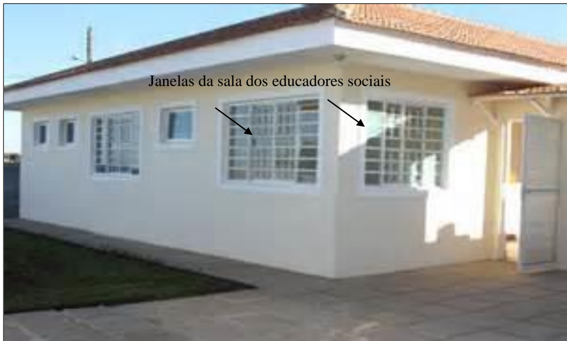
Figura 9 – Modelo da fachada frontal interna da nova estrutura das unidades de semiliberdade
