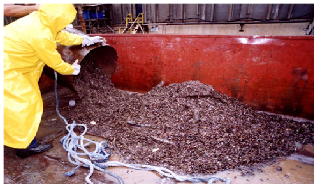
FIGURA 3: Operação de limpeza e retirada de mexilhão dourado
