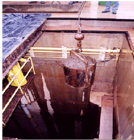
FIGURA 2: Remoção de mexilhão dourado de planta hidrelétrica
