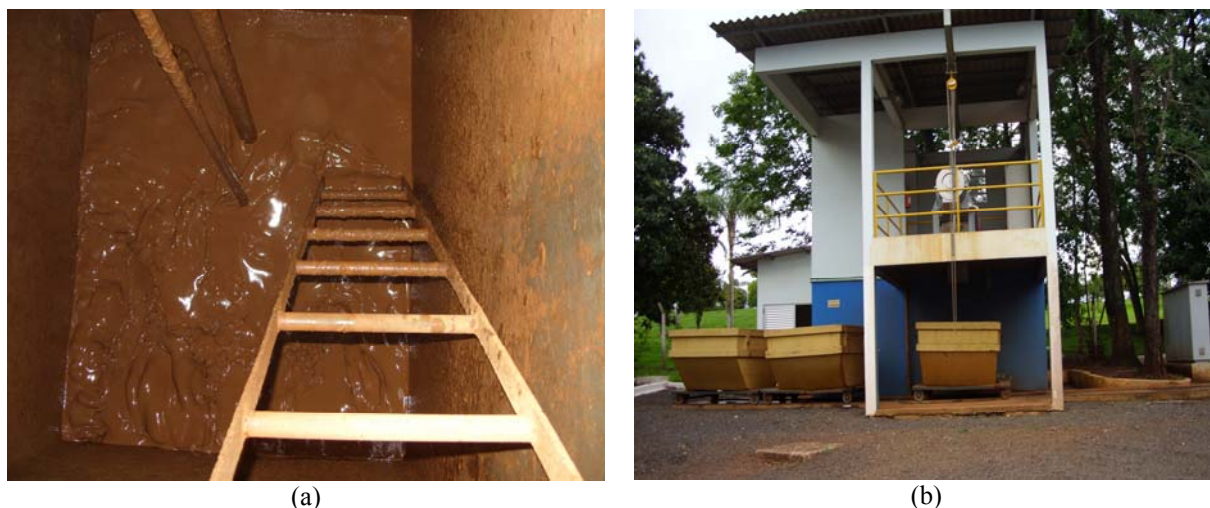
Figura 3.3 – (a) Lodo sendo descarregado pelo decantador, (b) Maquinário de centrifugação com acondicionamento em contêineres.
