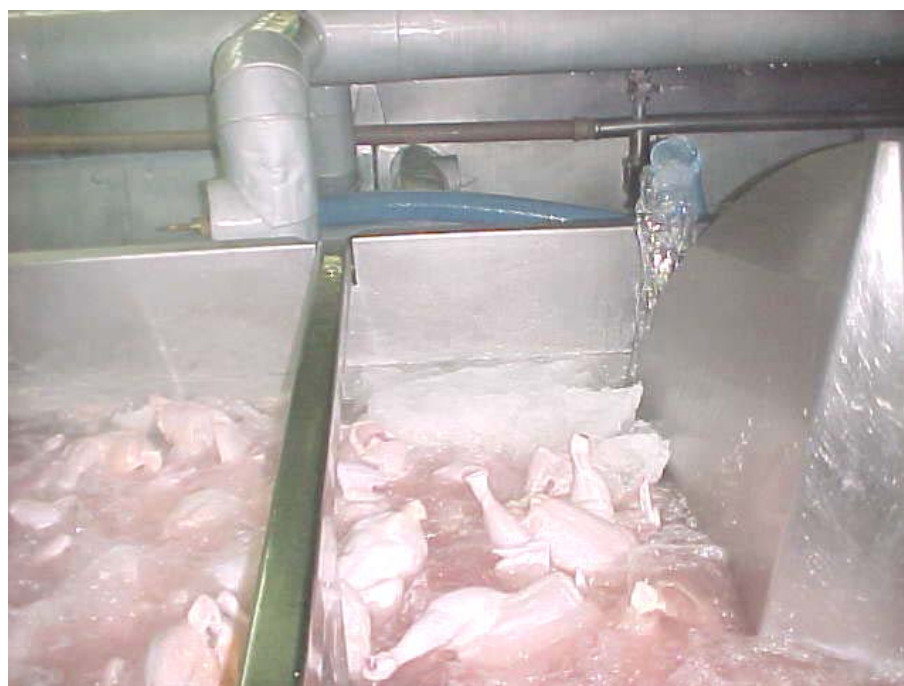
Figura 05 – Chiller com gelo sobrenadante.
