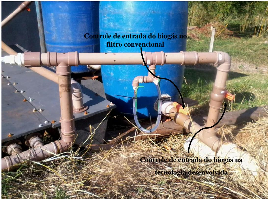
Figura 15. Instalação do sistema de controle de entrada do biogás na tecnologia desenvolvida ou no filtro convencional.
