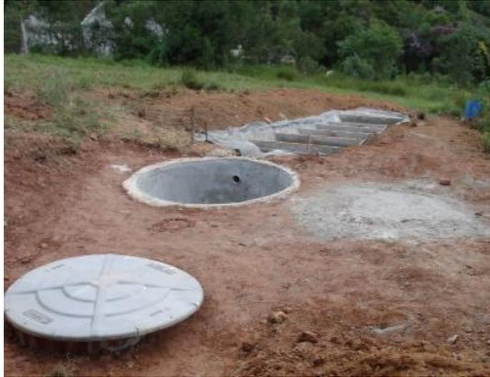
**Figura 2.8** Construção de um biodigestor (com tampa) seguido de filtro biológico.
