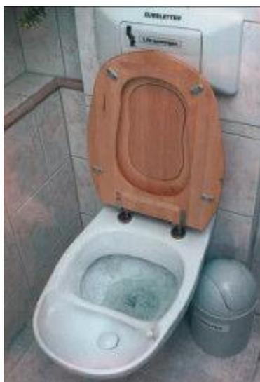
**Figura 2.3** Vaso compartimentado para coleta de água marrom.
