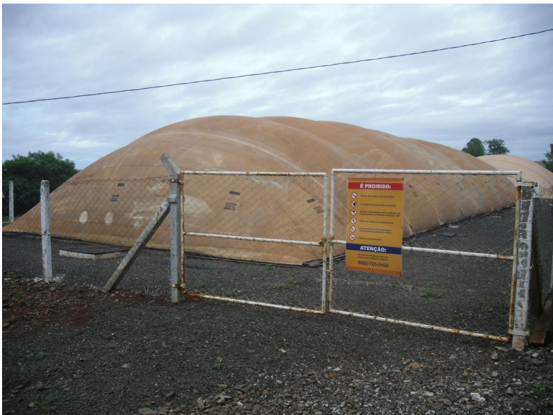
Figura 4.5 - Unidades de Biodigestores
