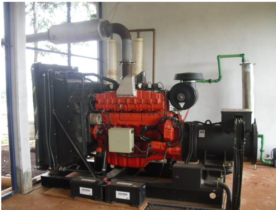
Figura 4.13 – Gerador, 330 kVA.
