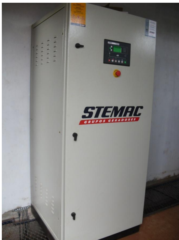
Figura 4.14 - Painel de Controle/Comando - Fornecido pela empresa Woodward Fonte: Foto tirada pela autora – UPL Lar – Serranópolis
