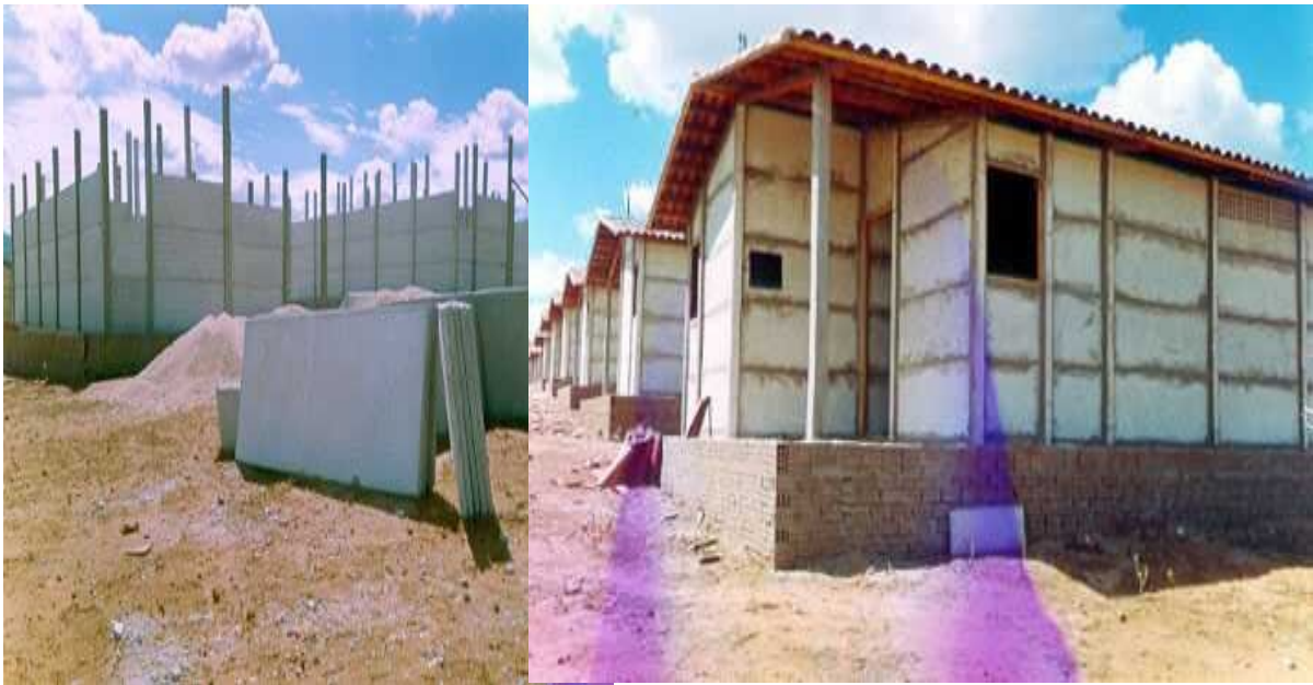
Fig.08: As placas e a construção das moradias em Vila Nova de Pedro Velho
