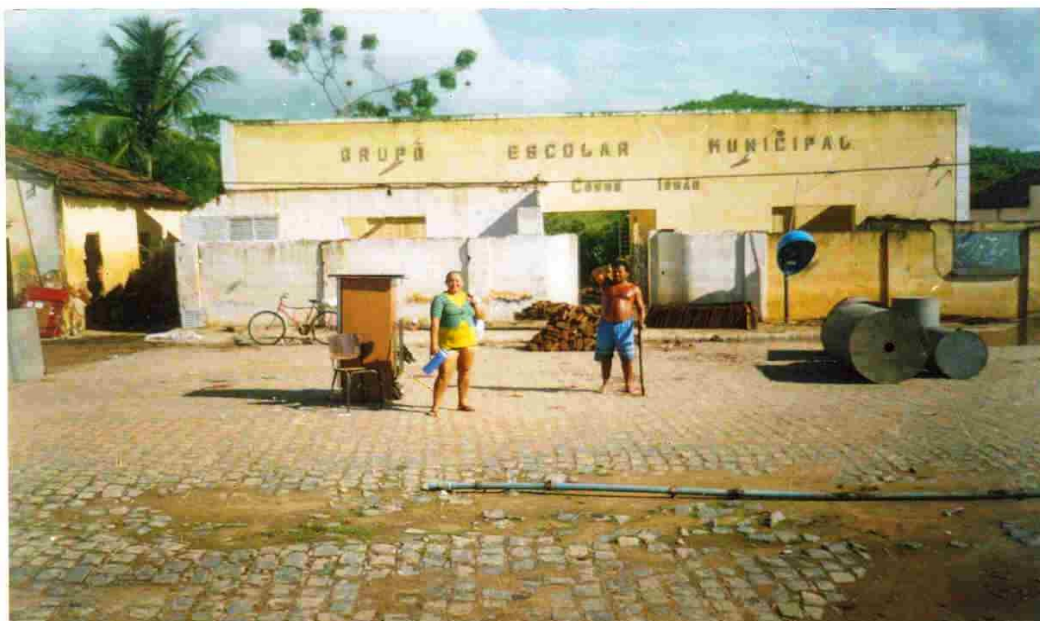
Fig. 18: Foto do Grupo Escolar Municipal sendo demolido no momento a chegada das águas de Acauã
