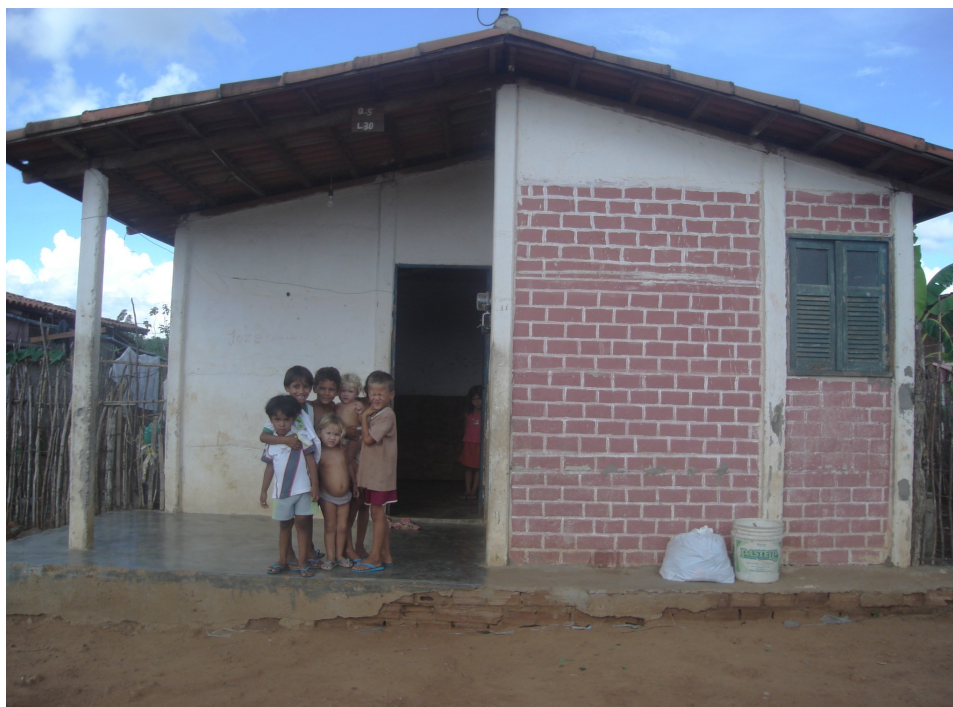
Fig. 07: Fachada de uma das casas de Vila Nova de Pedro Velho com os “retoques” feitos na lateral
