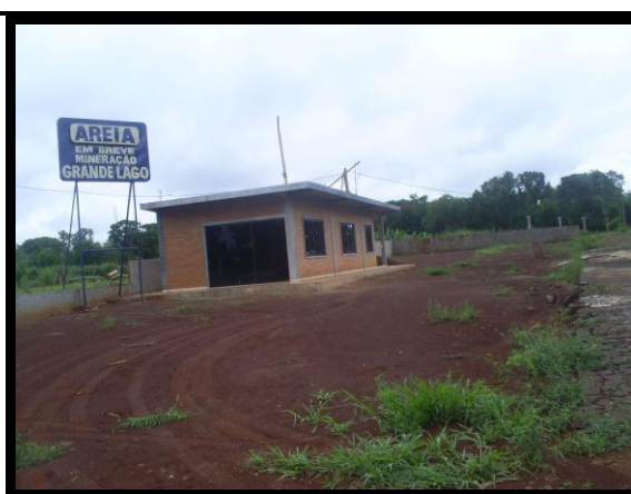
24. Foto: Início das instalações da “Mineração Grande Lago”.
