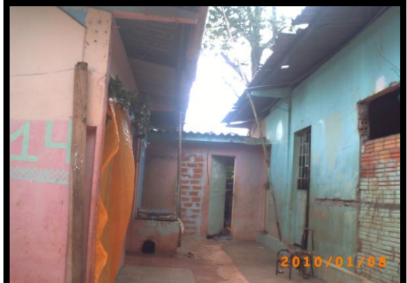
4. Foto: À direita parte do bloco 3 e à esquerda parte do bloco 4
