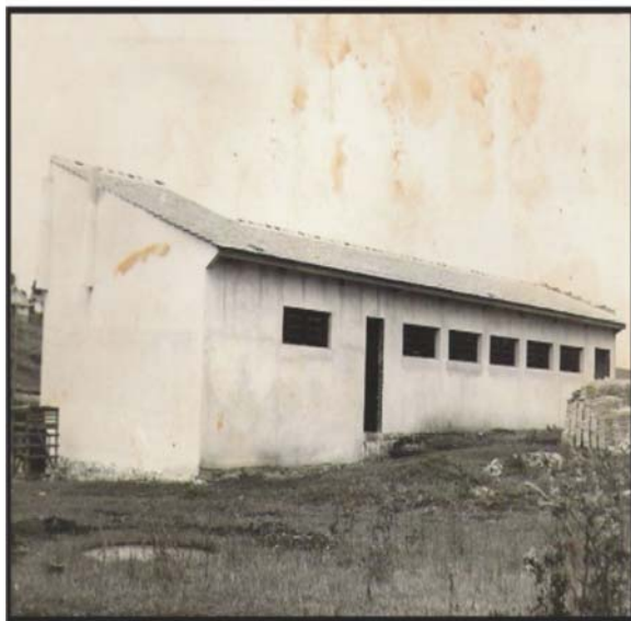
FOTO 1: Ampliação do frigorífico (1974/75) Fonte: Acervo particular de Alcides Massaro
