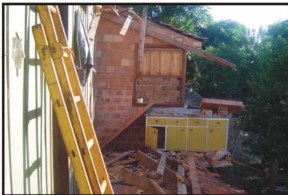
FOTO 27: Desmoronamento da casa da Sirlei Francisco dos Santos Fonte: Valdemir José Sonda, 24 dez. 2005
