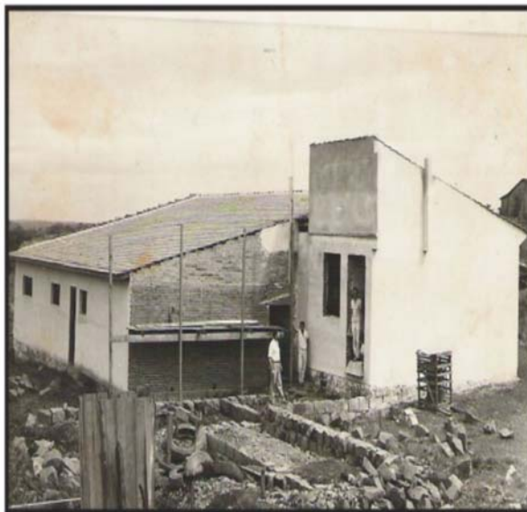
FOTO 2: Ampliação do frigorífico (1974/75) Fonte: Acervo particular de Alcides Massaro
