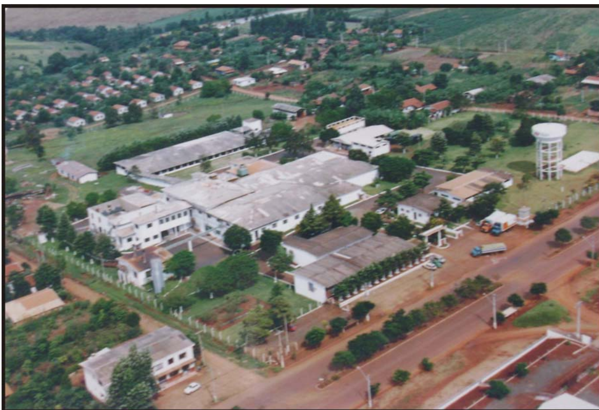
FOTO 3: Visão do complexo industrial em 1979
