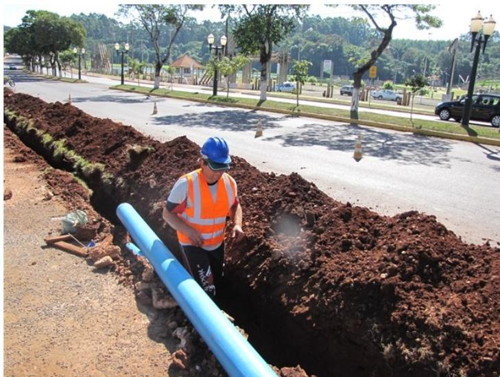
**Figura 33 - Instalação da rede adutora de captação de água em Marechal Cândido Rondon.**
