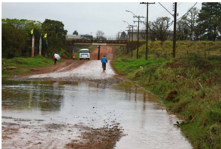
Ilustração 11: Avenida Dr. Aragão de Mattos Leão Filho, principal via de acesso, inundada pelo Rio Cascavelzinho.
