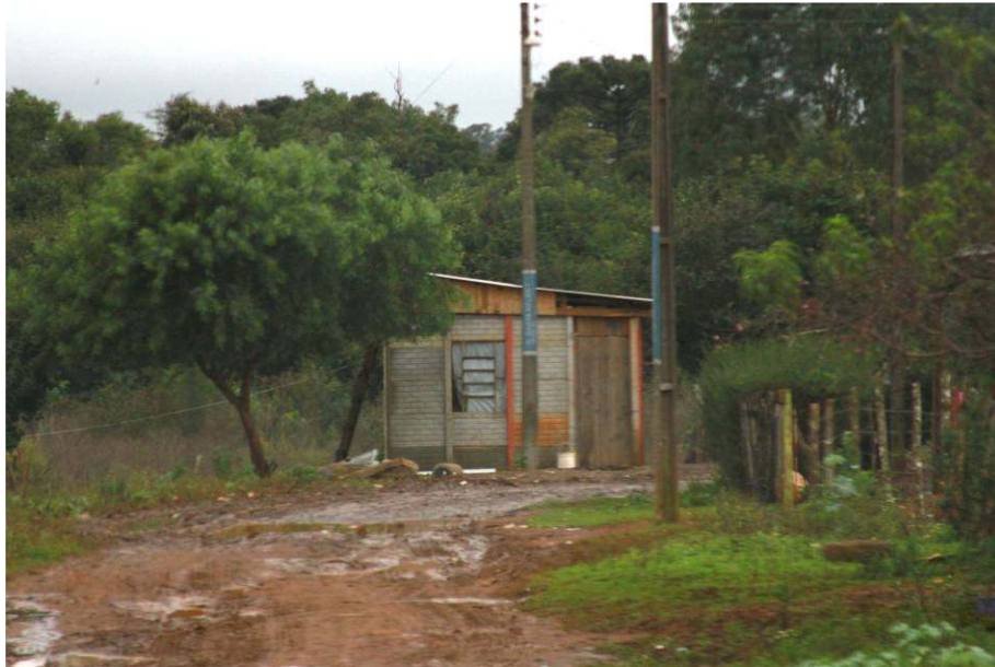
Ilustração 05: Casa construída na margem do Rio Cascavelzinho.
