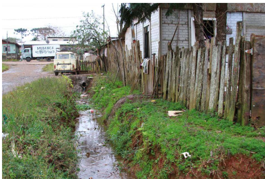
Ilustração 10: Precárias condições infraestruturais do Bairro Jardim das Américas. Fonte: arquivo pessoal do autor, 2013.
