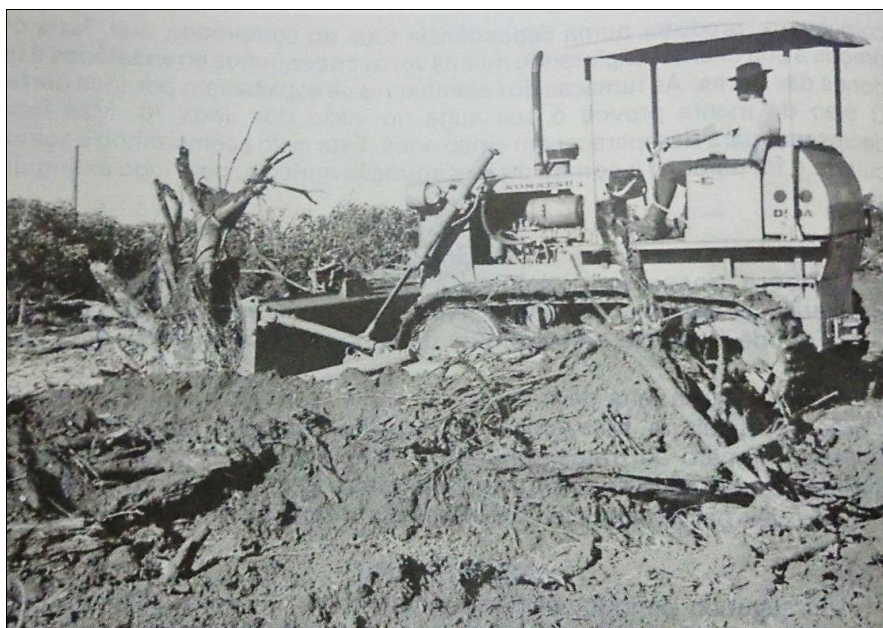
FIGURA 18 – Destoca com utilização de retroescavadeira em Palotina Fonte: Reginato (1979, p. 178)
