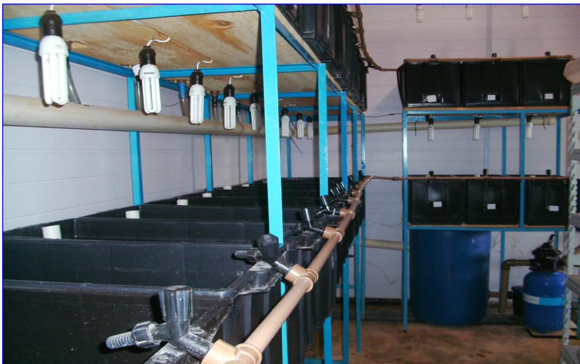
Figura 26. Sistema para criação de larvas com filtro mecânico e aquecimento controlado
