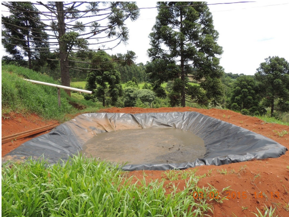
Figura 22 – Esterqueira para armazenamento dos resíduos líquidos
