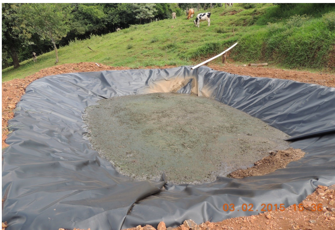
Figura 26 – Esterqueiras com geomembrana
