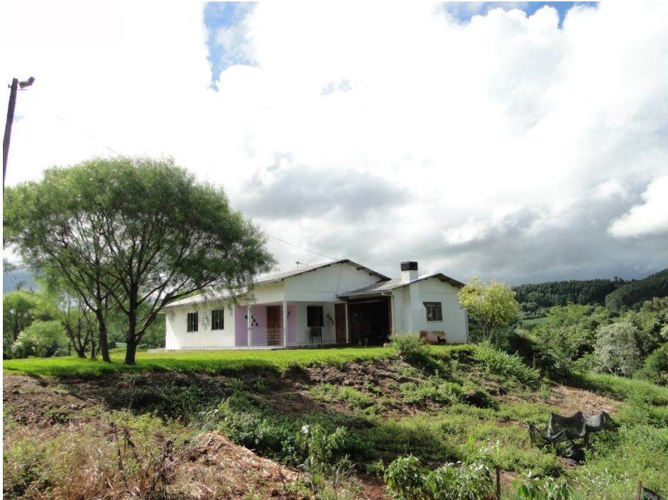
Figura 4 – Residências de alvenaria
