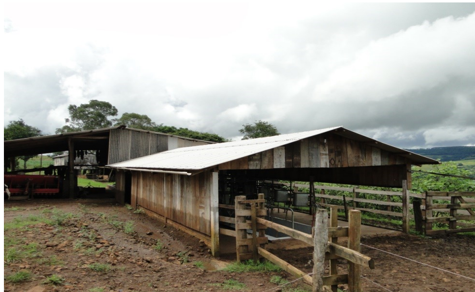
Figura 12 – Estruturas de madeira
