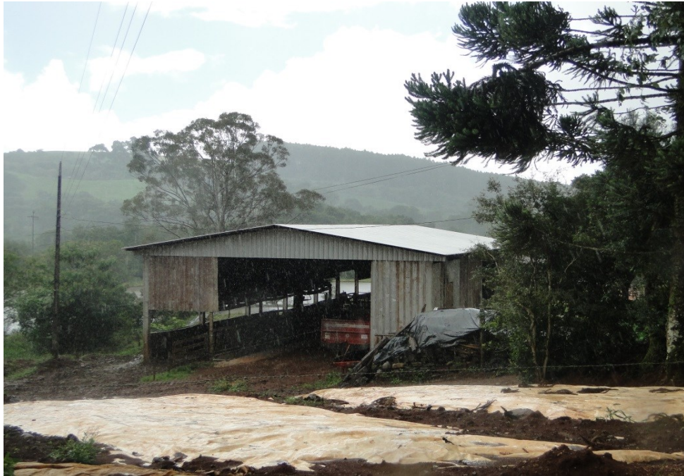
Figura 11 – Estrutura de alvenaria para a bovinocultura de leite
