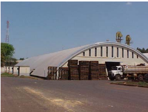
T3 – Armazém “climatizado”
