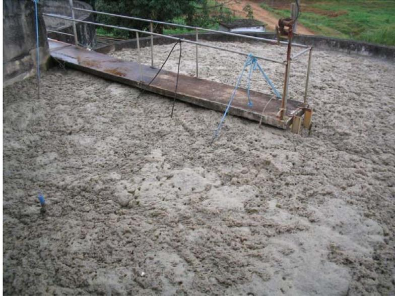
Figura 28. Reator 1, completamente cheio, pronto para iniciar a drenagem.
