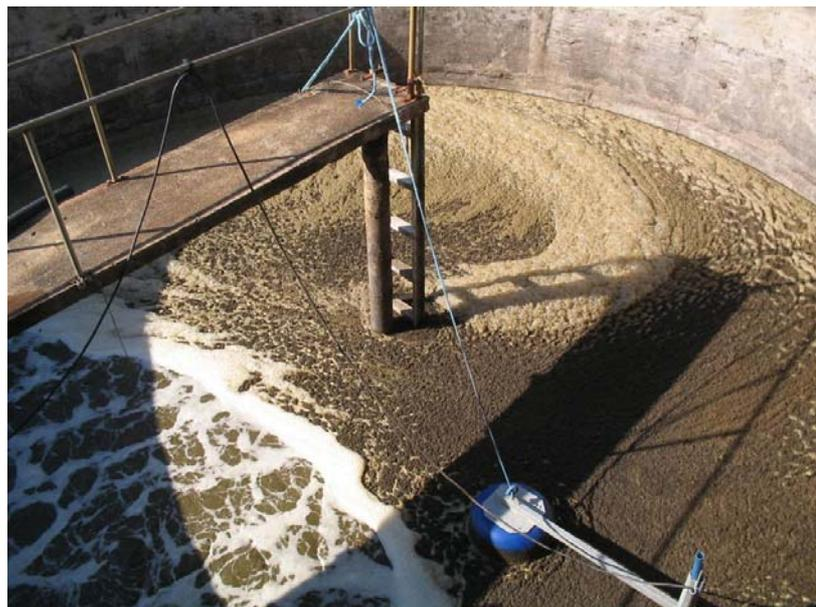
Figura 24. Interior do tanque de aeração.
