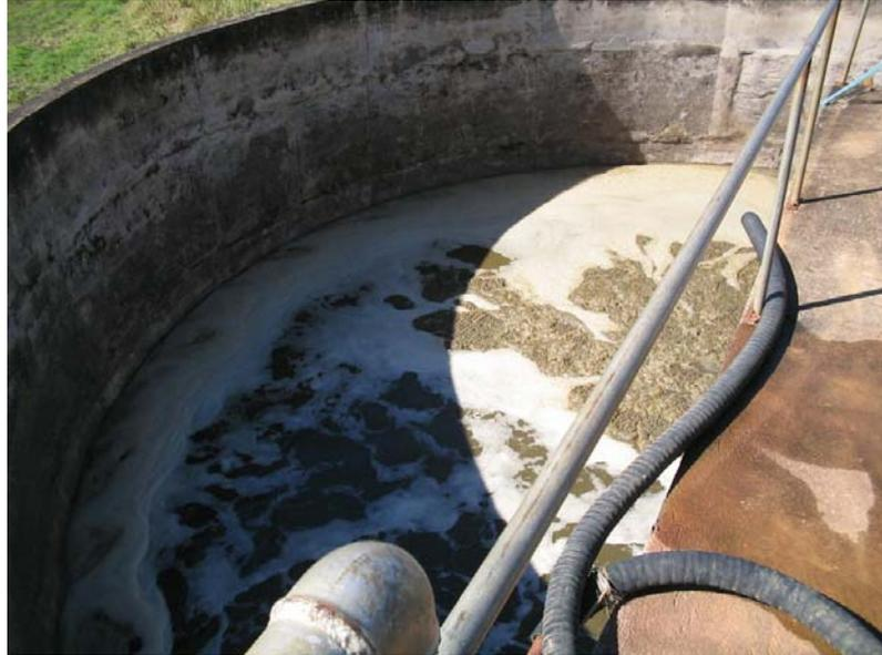
Figura 12. Tanque para tratamento dos dejetos líquidos.
