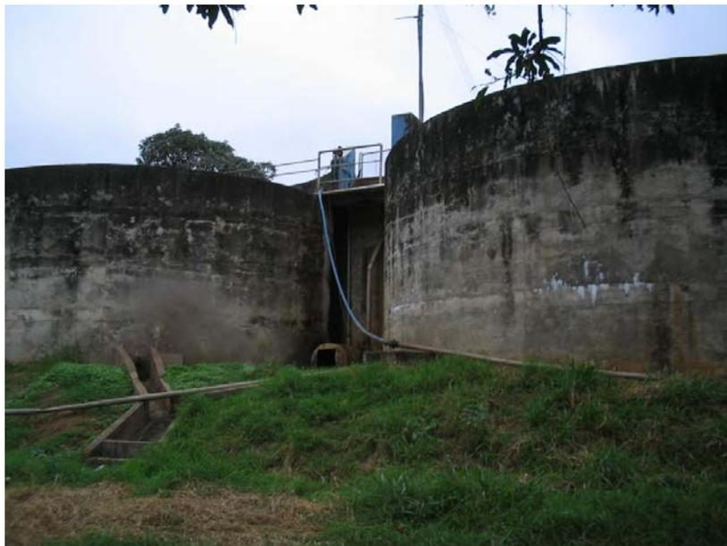
Figura 18. Tanques de aeração que recebem os dejetos líquidos.
