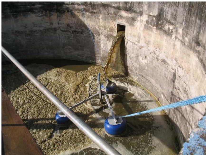
Figura 19. Tanque de aeração recebendo os dejetos líquidos através da canaleta.
