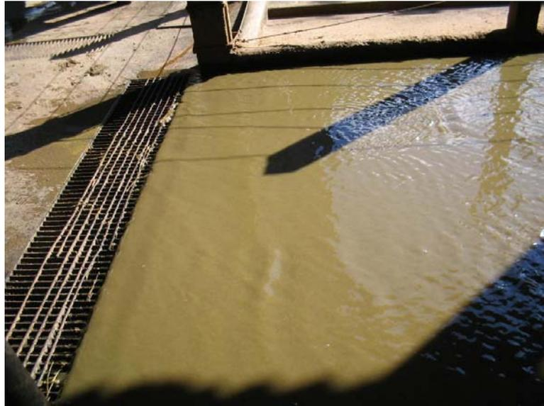
Figura 21. Canaletas de concreto que conduzem os dejetos líquidos aos tanques de aeração.
