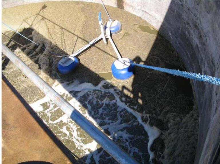
Figura 20. Aerador-misturador submersível que promove a oxidação e homogeneização da massa líquida.
