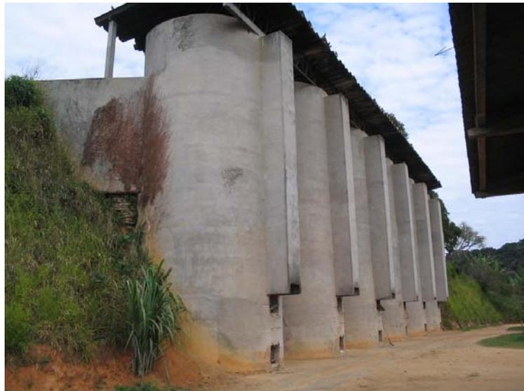
Figura 11. Bateria de seis silos de encosta.
