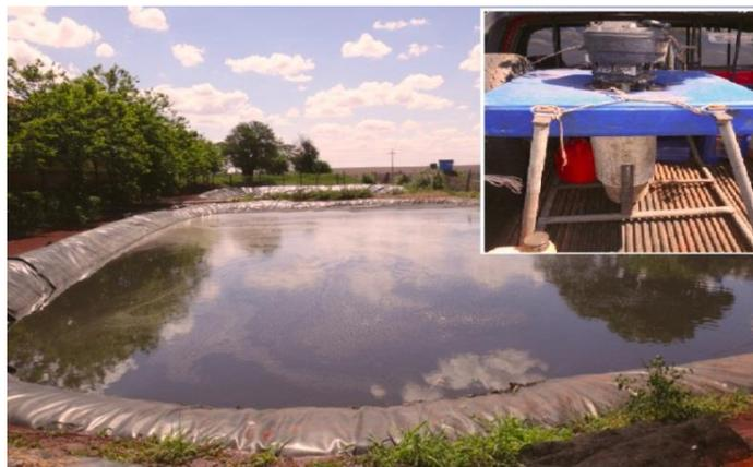
Figura 2 - Lagoa de estabilização anaeróbia, agitador mecânico para dejetos decantados.
