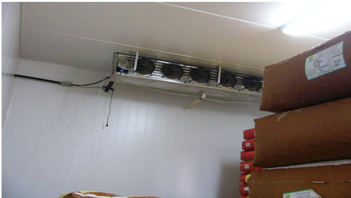
Refrigerador de Grãos modelo PCS 12 da marca Coolseed (vista interna).
