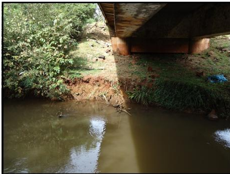
FIGURA 18 – Migração lateral na margem esquerda no rio Lopeí abaixo de ponte (Ponto 28), BR 467 (Foto: Leandro Neri Bortoluzzi, data: 02/05/2011).
