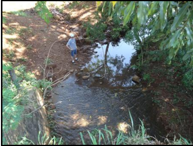
FIGURA 22 – Vista do canal a montante do bueiro celular de concreto no rio São João (Ponto 40), PR 495 (Foto: Leandro Neri Bortoluzzi, data 06/10/2011).
