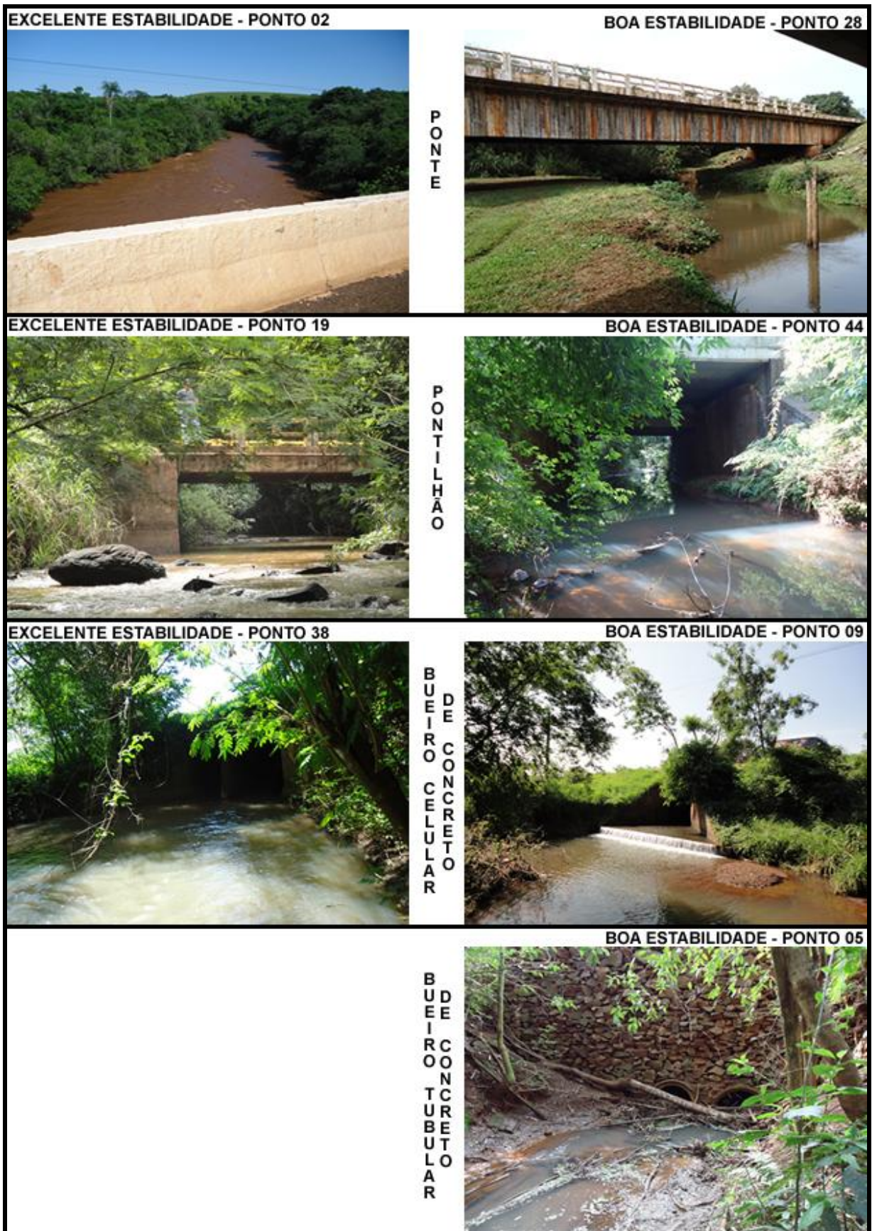
FIGURA 29 – Exemplo de níveis excelente e boa estabilidade para cada tipo de estrutura. Não há figura referente a excelente estabilidade em bueiro tubular de concreto, pois o mesmo não foi encontrado no estudo. (Confecção: Leandro Neri Bortoluzzi).
