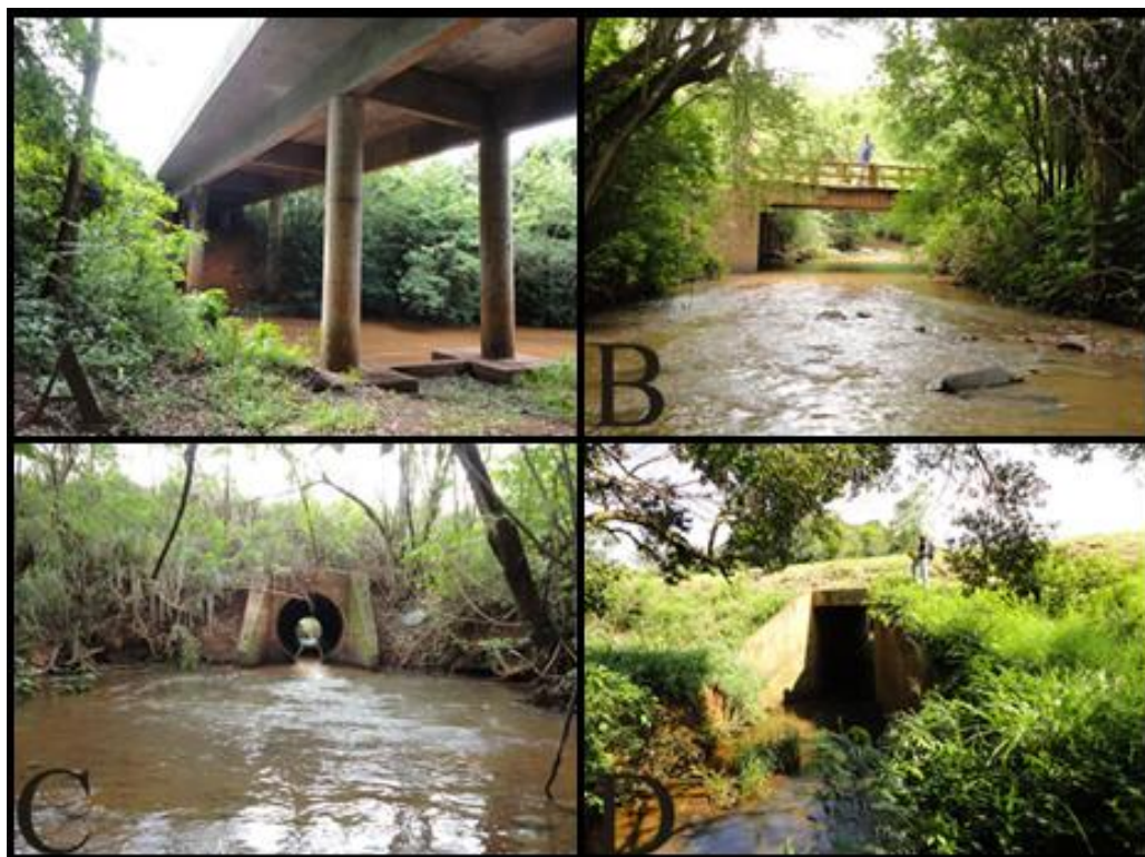
FIGURA 5 – Estruturas analisadas neste estudo, onde, A/ponte (Ponto 15, rio Guaçu, PR 239), B/pontilhão (Ponto 19, arroio Fundo, rodovia municipal de Marechal Cândido Rondon), C/bueiro tubular de concreto (Ponto 13, córrego Quatro Pontes, BR 163) e D/bueiro celular de concreto (Ponto 10, córrego Guavirá, BR 163). (Fotos: Leandro Neri Bortoluzzi, datas: A - 02/12/2010, B - 02/12/2010, C – 25/10/2010, D - 02/12/2010 ).
