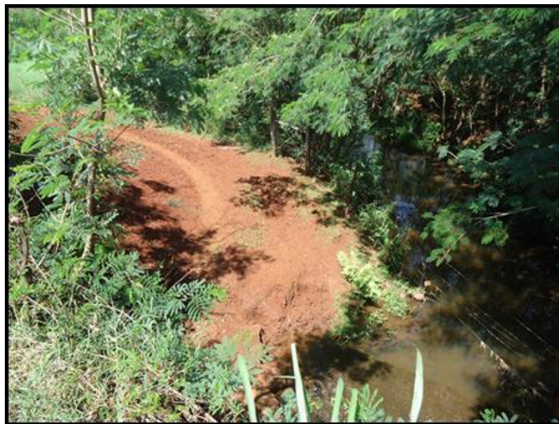
FIGURA 19 – Pisoteamento do gado para ter acesso à água provocando erosão a montante do bueiro celular de concreto no córrego Pacurí (Ponto 35), PR 495 (Foto: Leandro Neri Bortoluzzi, data: 06/10/2011).
