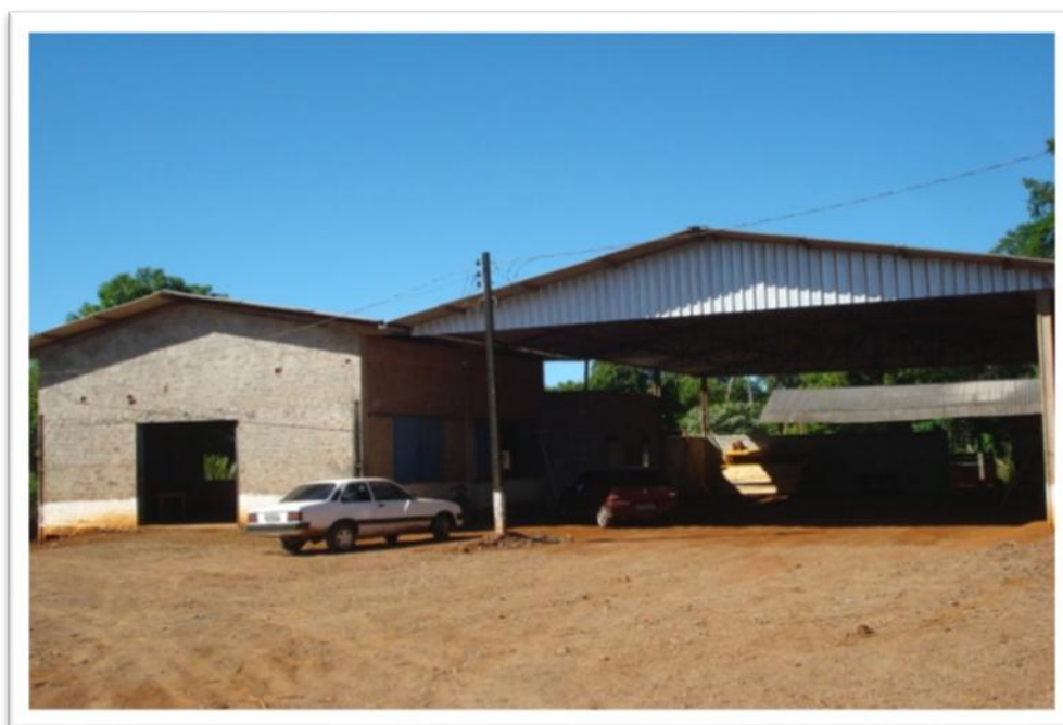
Figura 21 - Sede da Comunidade: Pavilhão de pré-moldado - 2010
