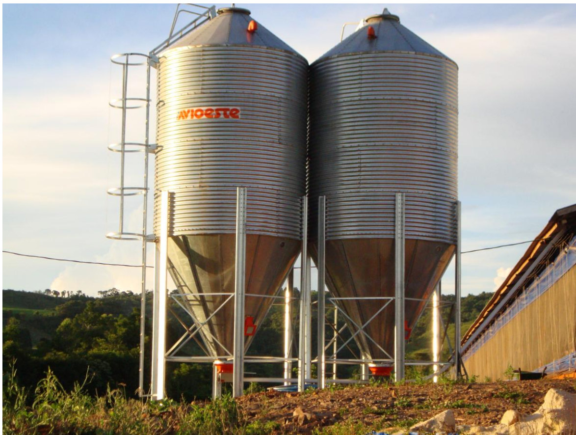
FIGURA 6 - Silos de aviário - padrão atual
