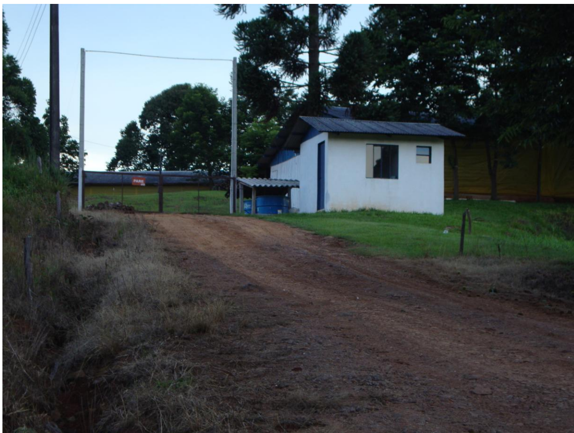
FIGURA 5 - Escritório e arco de desinfecção de aviário
