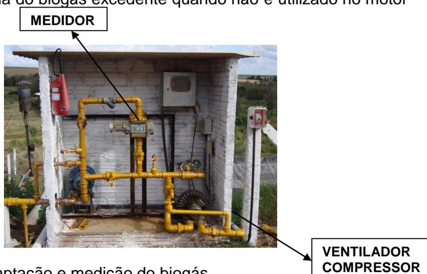
Figura 10 - Sistema de captação e medição do biogás
