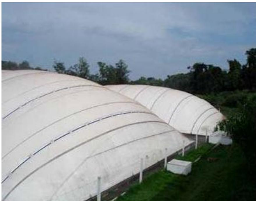
Figura 3 - Biodigestor tipo canadense
