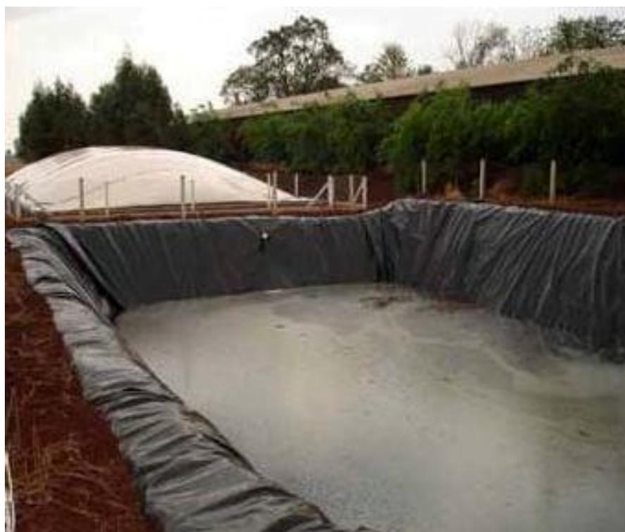
Figura 4 - Biodigestor seguido de esterqueira revestida
