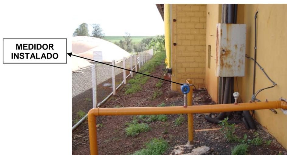
Figura 14 - Medidor de vazão mássica Thermatel TA2 Enhanced (MAGNETROL, 2011)
