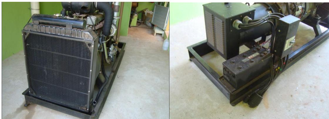
Figura 11 - Motor Gerador 100kVA instalado na propriedade
