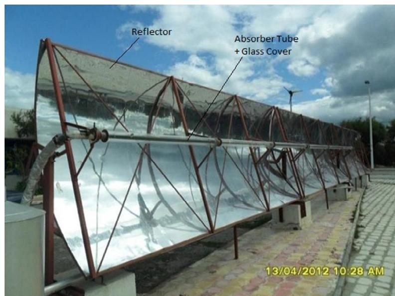
Figura 13: Concentrador de calha parabólica usado para aquecimento de ambientes.
