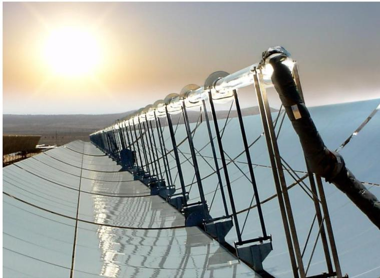
Figura 9: Coletor cilíndrico-parabólico.
