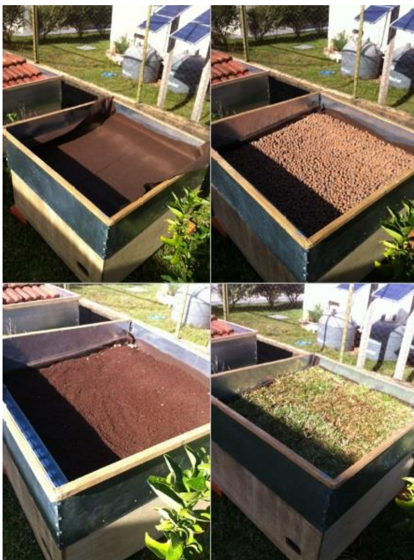
Figura 13: montagem do protótipo com o telhado verde na Unioeste / Cascavel.
