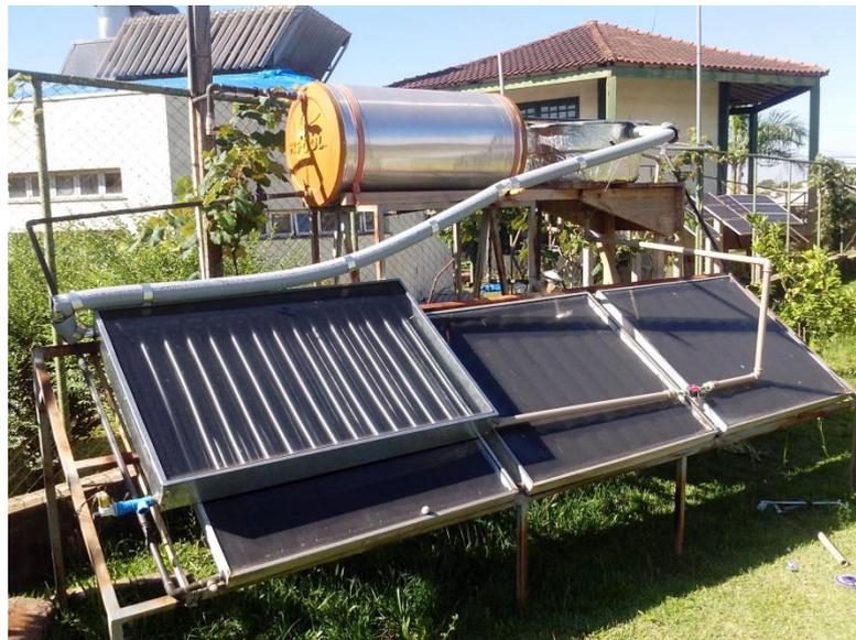
Figura 16. Conjunto placa termossolar – reservatório térmico instalado.
