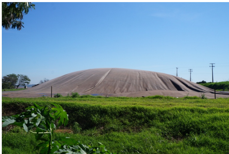
Figura 5 - Reator anaeróbico de fluxo tubular ( plug-flow ). Fonte: Arquivo pessoal
