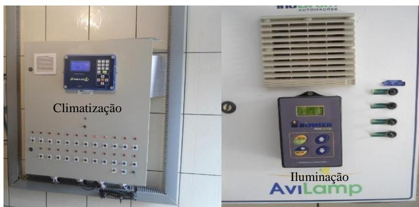
Figura 9. Painel de controle do sistema de ambiência e do sistema de iluminação do aviário 2.
