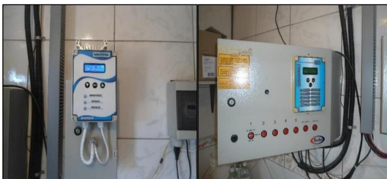
Figura 7. Painel de controle da iluminação e painel de controle dos fornos do aviário 1.
