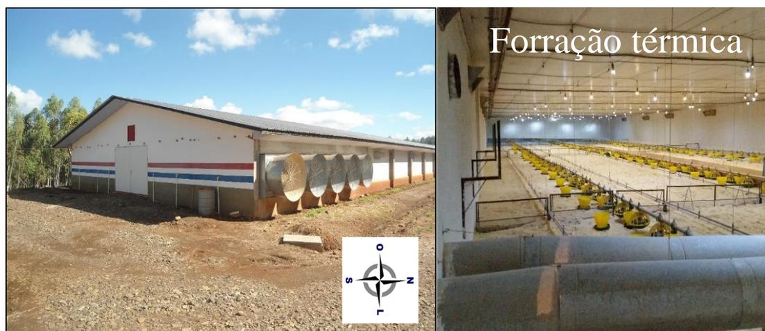
Figura 8. Aviário 2 com isolamento térmico e forração com manta térmica.
