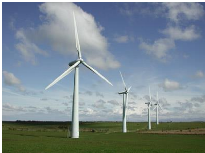
Figura 3: Aerogerador de eixo horizontal.
