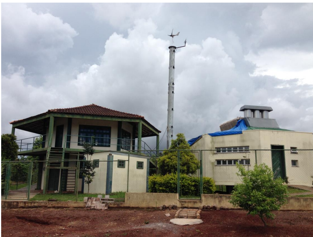
Figura 9: Projeto CASA – Local de instalação do aerogerador de pequeno porte.
