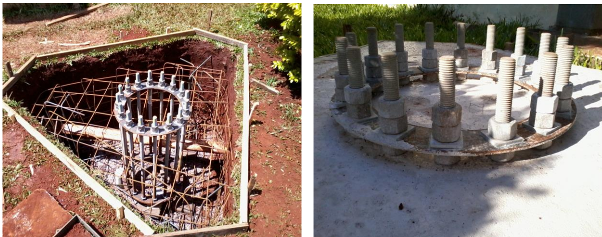
Figura 10: Fundação e estrutura interna.
