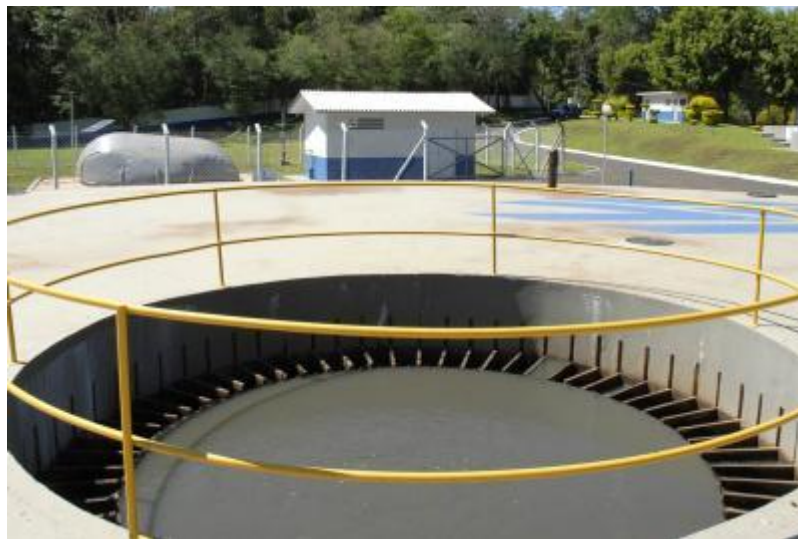
Figura 2 – Vista do vertedouro central do reator anaeróbio de lodo fluidizado (RALF) da ETE Ouro Verde e unidade de geração de energia a partir do biogás.
