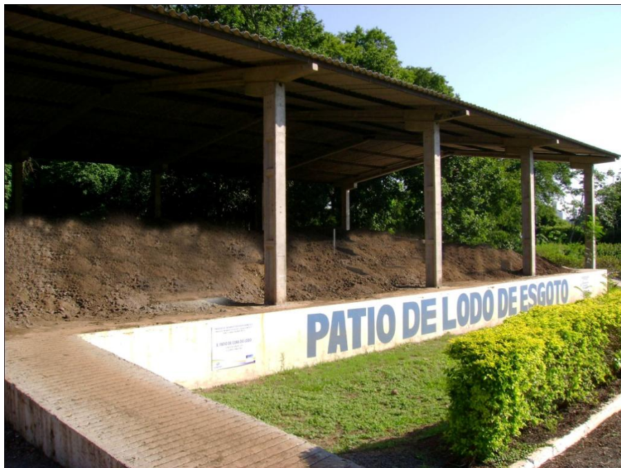
Figura 4 – Pátio de armazenamento de lodo de esgoto (biossólido) da UGL Ouro Verde.
