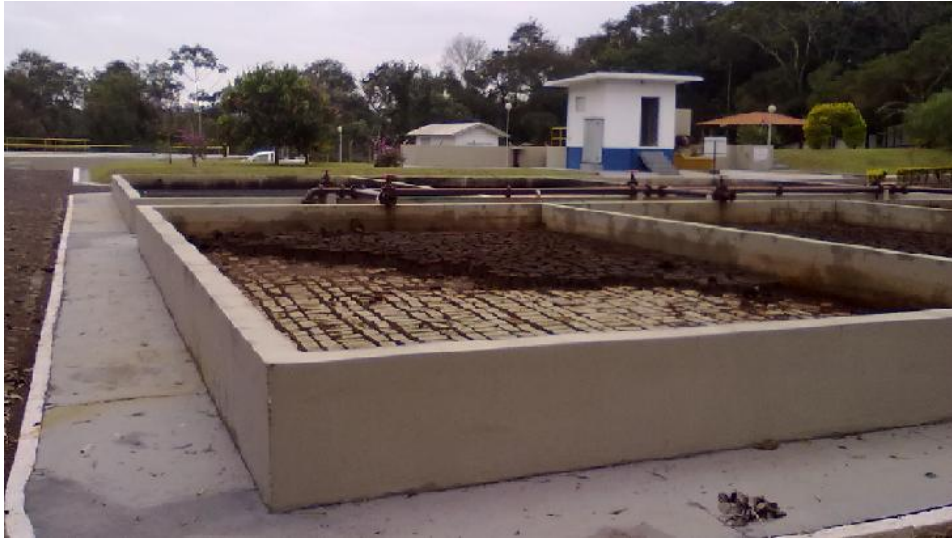
Figura 3 - Leito de secagem natural do lodo de esgoto da ETE Ouro Verde.
