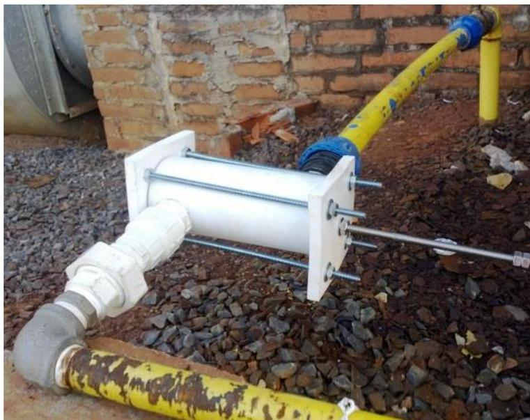
Figura 20: Fotografia da câmara de corrosão de PTFE montada no duto de alimentação de biogás.
