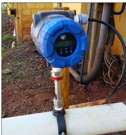
Figura 10. Medidor de vazão da marca Magnetrol
