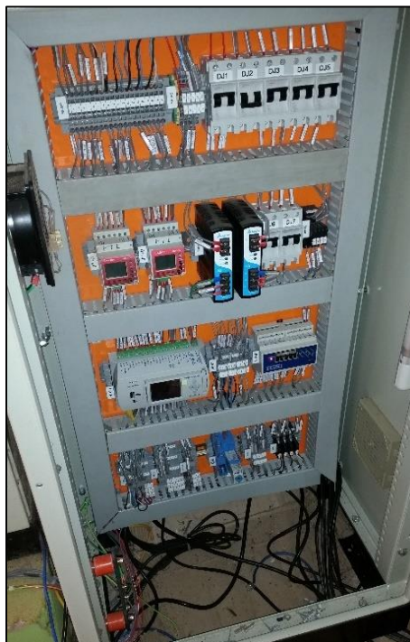
Figura 8. Painel de monitoramento instalado na propriedade
