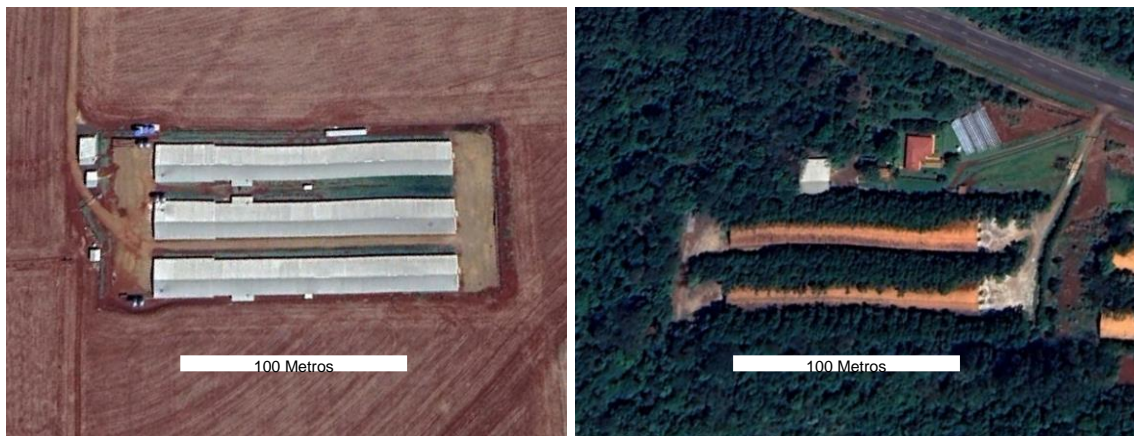
Figura 8 – Vista aérea aviário Dark House e convencional, Marechal C. Rondon, PR.
