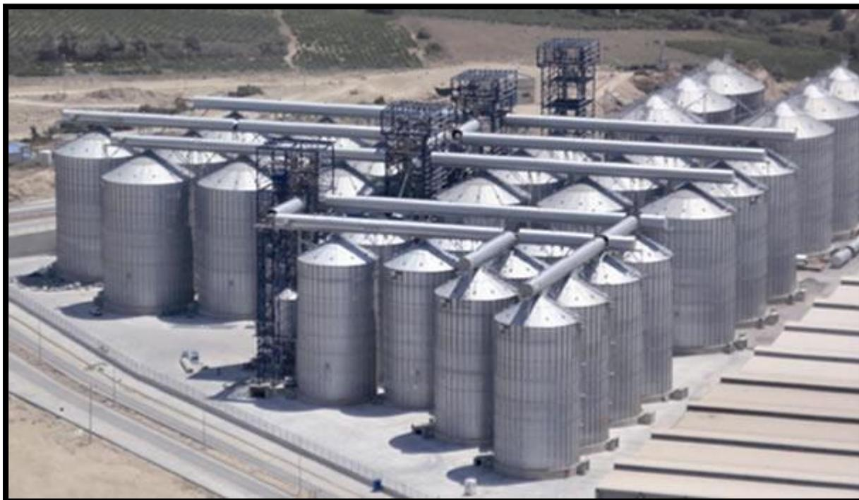
Figura 8 Bateria de silos metálicos
