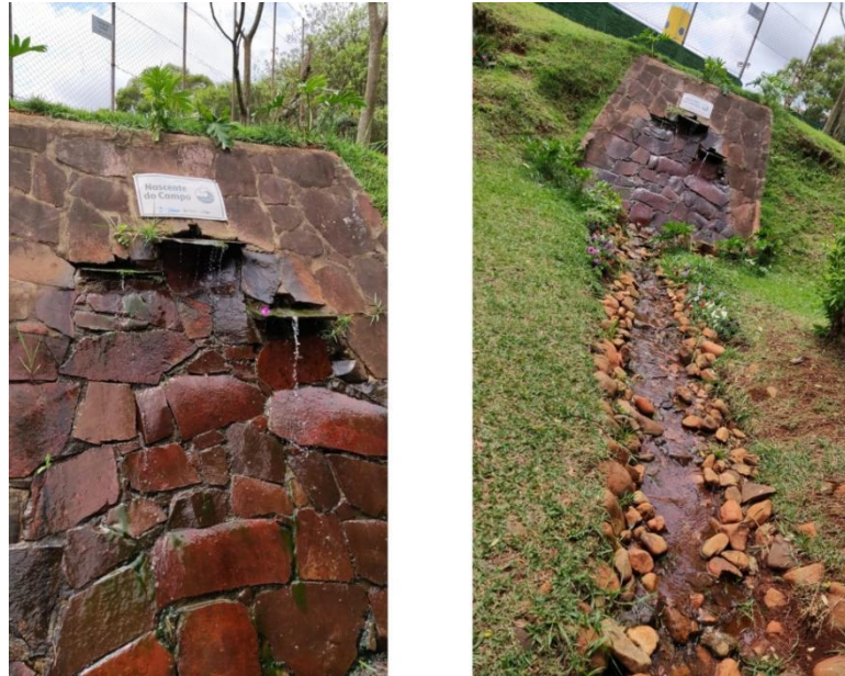
(P1) Fonte Parque Tarquínio.
