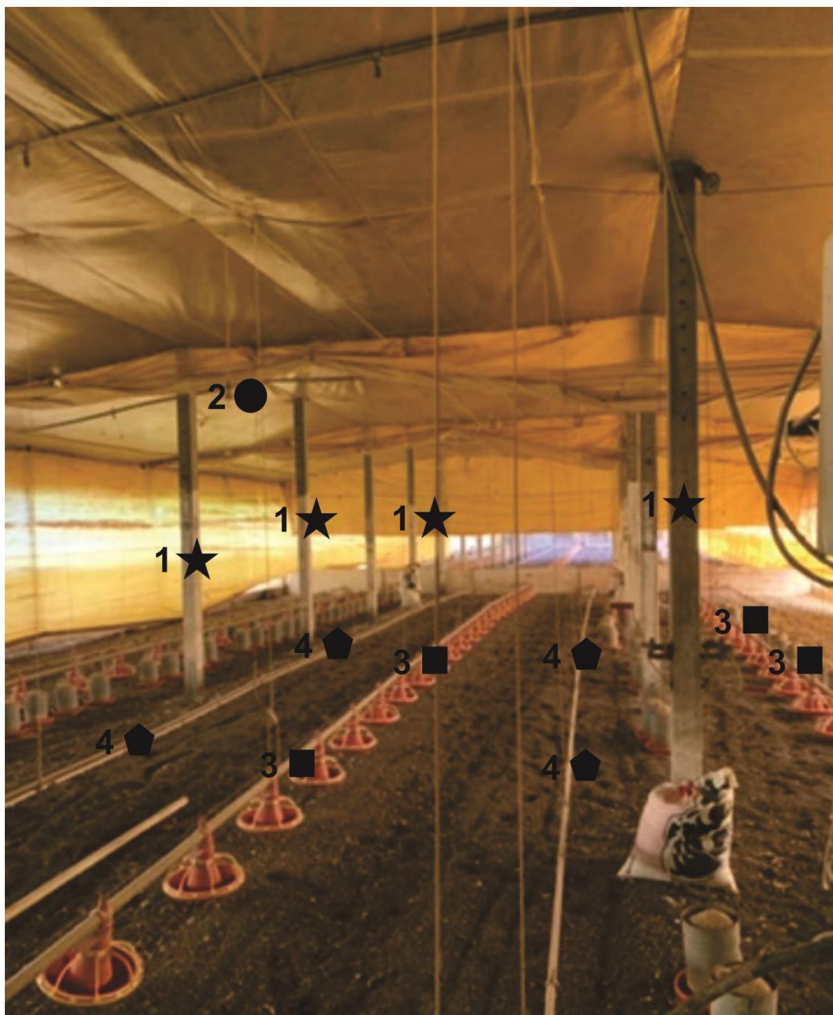
Figura 7: Ambiente interno do aviário convencional. 1-estrela: Pilares de sustentação, 2-bola: Lâmpadas instaladas, 3-quadrado: Comedouro das aves, 4-pentagono: Bebedouro das aves. Fonte: Próprio autor, 2023.
