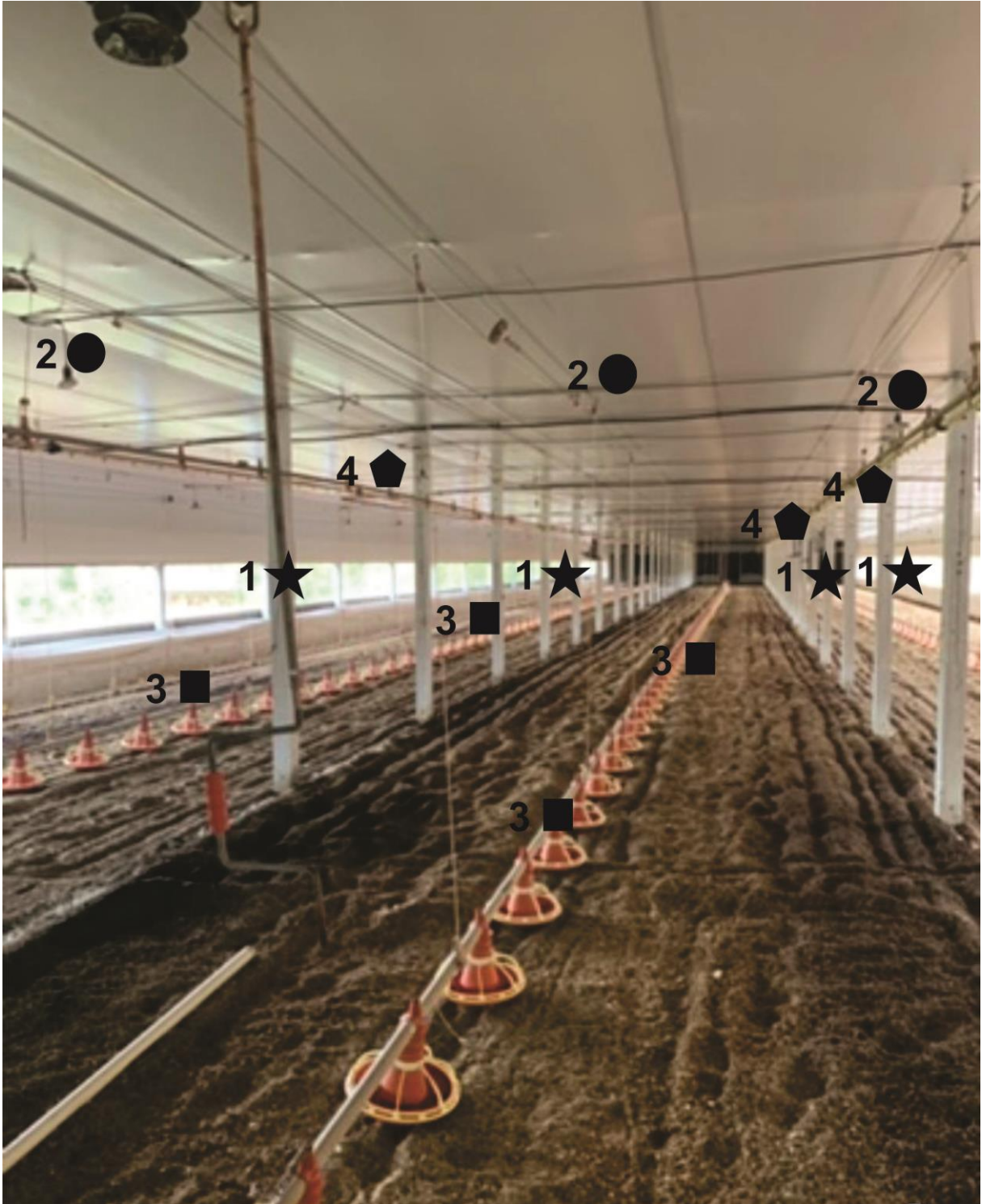
Figura 14: Ambiente interno do aviário Dark House . 1-estrela: Pilares de sustentação, 2-bola: Lâmpadas instaladas, 3-quadrado: Comedouro das aves, 4-pentagono: Bebedouro das aves.
