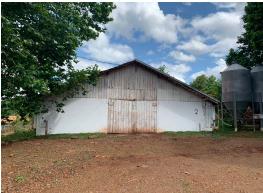
Figura 4: Elevação frontal do aviário convencional. Fonte: Próprio autor, 2022.
