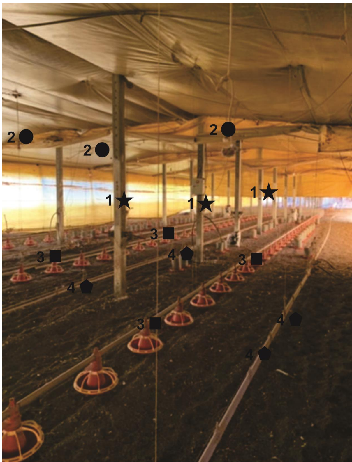
Figura 6: Ambiente interno do aviário convencional. 1-estrela: Pilares de sustentação, 2-bola: Lâmpadas instaladas, 3-quadrado: Comedouro das aves, 4-pentagono: Bebedouro das aves.
