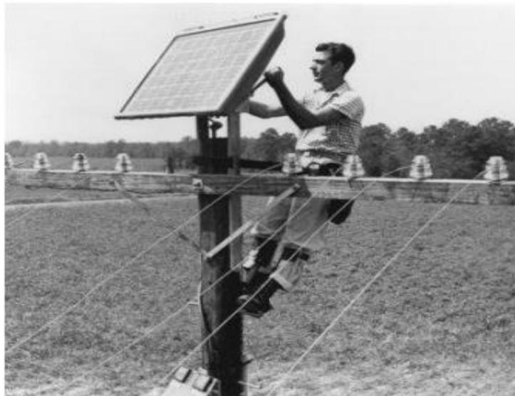
Figura 4 – A primeira aplicação de uma célula solar de silício em uma rede de telefonia
