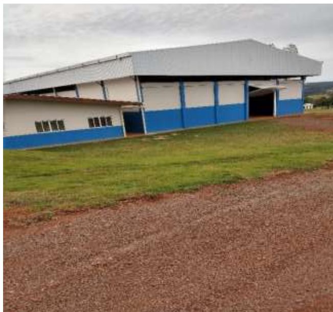
IMAGEM 9 – Vista externa do novo barracão onde funcionará a ACATOL
