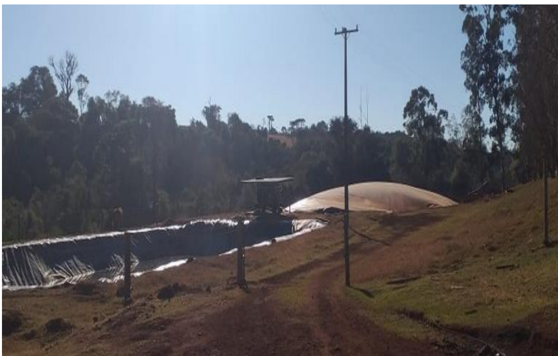
Figura 11 - Sistema de biodigestor utilizado para produção de biogás no Brasil. Fonte: Autor, 2021.
