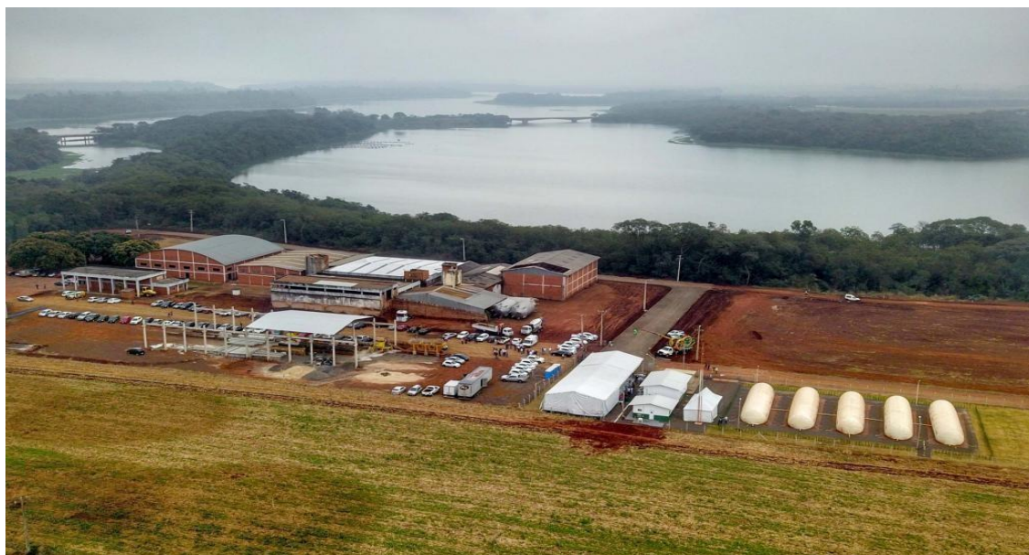
Figura 16 - Usina de Biogás/energia elétrica em Entre Rios do Oeste – PR. Fonte: Fundação Joaquim Nabuco/2020.
