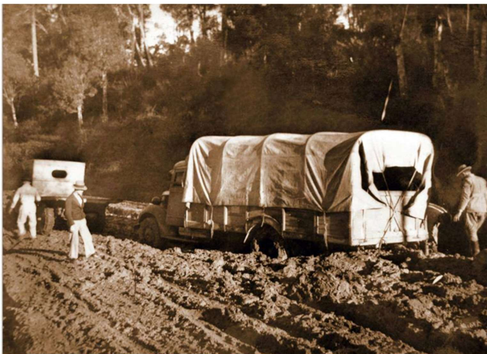
Figura 8 - Estrada de Acesso a Foz do Iguaçu
