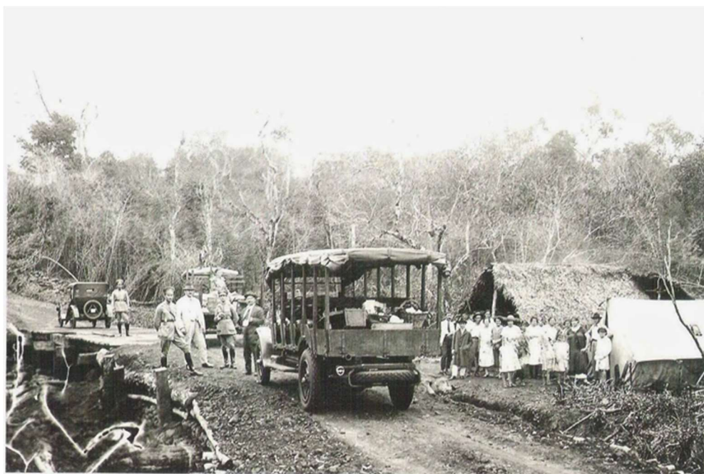
Figura 7 - Ponte sob o Rio Tamanduazinho
