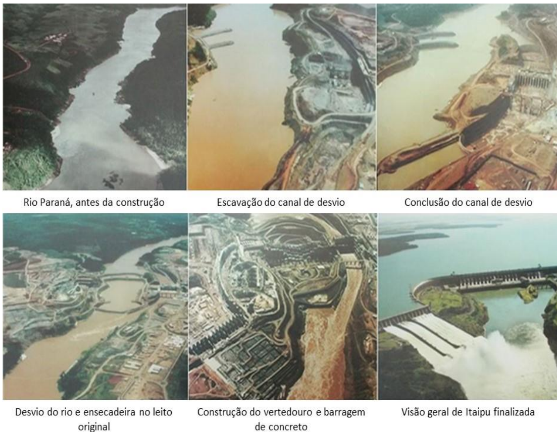
Figura 1. Etapas da construção da Hidrelétrica de Itaipu
