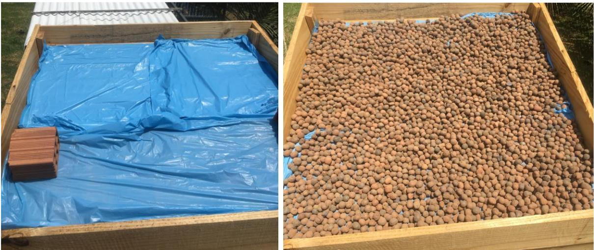
Figuras 18 e 19 – Camadas da montagem do protótipo do telhado verde, manta impermeabilizante e argila expandida
