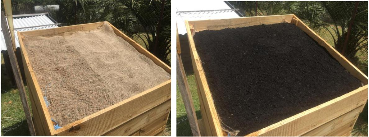
Figuras 20 e 21 – Camadas da montagem do protótipo do telhado verde, tecido geotêxtil e substrato arenoso
