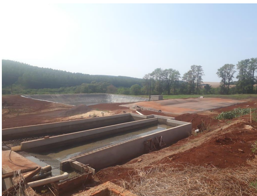
Figura 31 - Instalações do biodigestor na propriedade.
