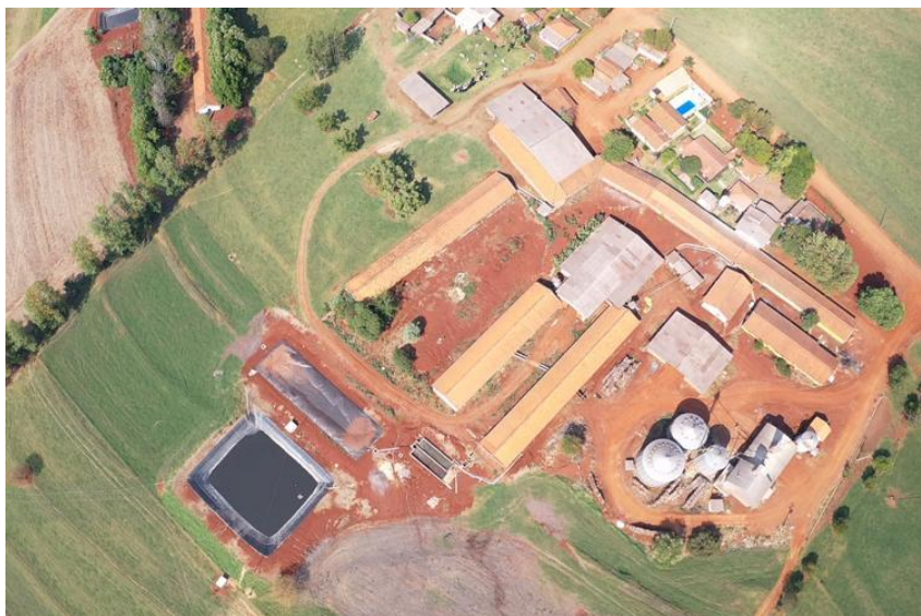
Figura 30 - Imagem aérea da propriedade e do biodigestor.
