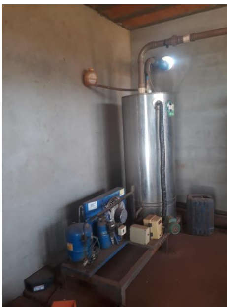
Figura 29 - Filtro para retirada de umidade do biogás.
