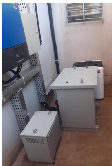
Figura 34 - Instalação dos inversores e autotransformadores no local..
