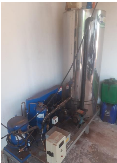
Figura 32 - Filtro utilizado para a remoção de umidade do biogás.
