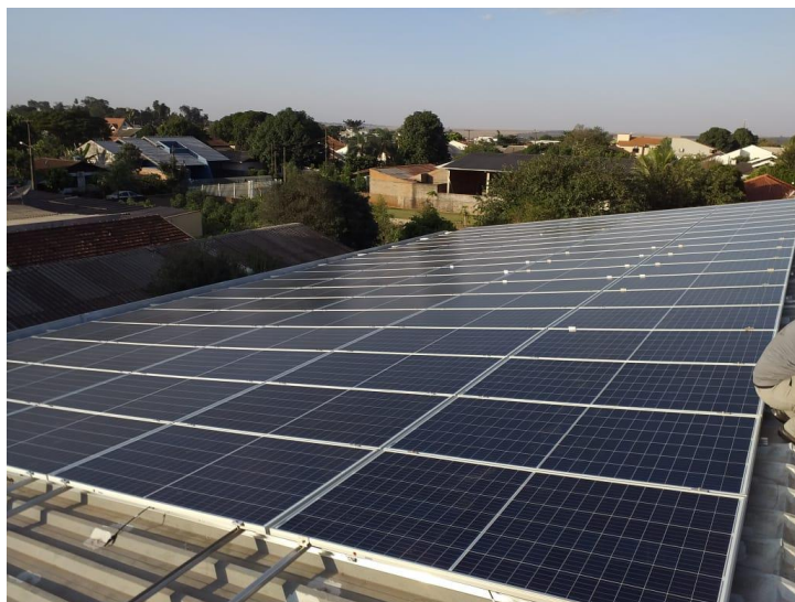
Figura 33 - Painéis fotovoltaicos instalados.
